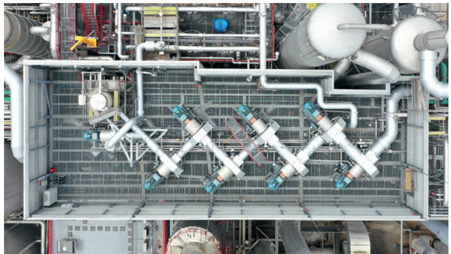
Tecnología de bomba de calor: Línea de compresión de vapor con ventiladores de MVR de PILLER
