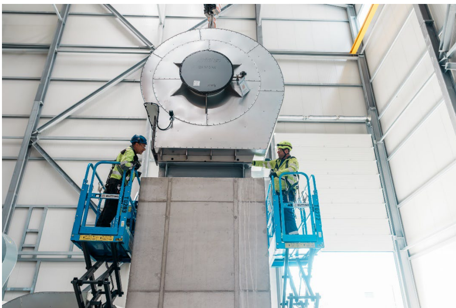
图片标题：在巴斯夫进行设备的预安装和固定工作。
