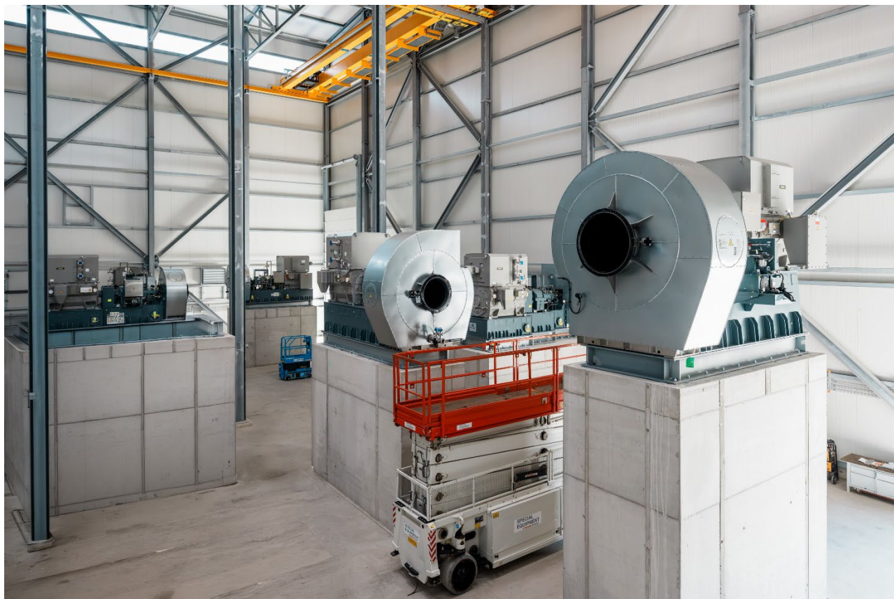
图片标题：首批 PILLER 压缩机已成功就位：随着设备被放置在指定的混凝土基座上，巴斯夫这一大型项目又达成了一项关键里程碑。
