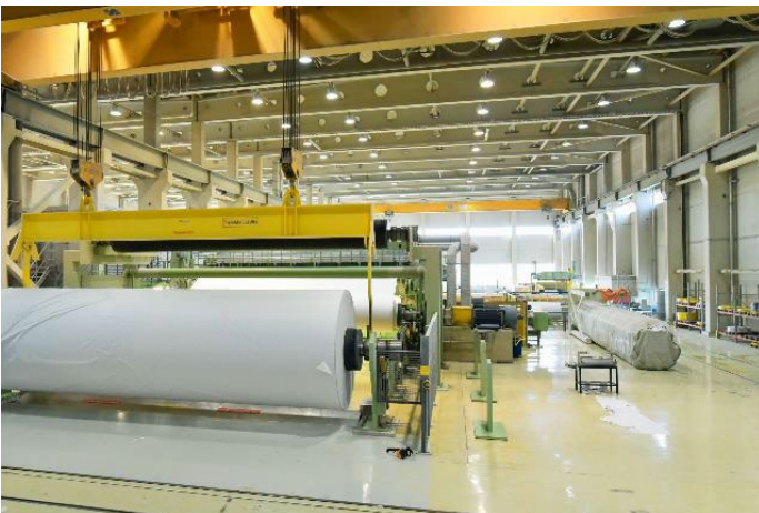
图 2: 蒸汽对于造纸生产至关重要。(© Piller Blowers & Compressors)
