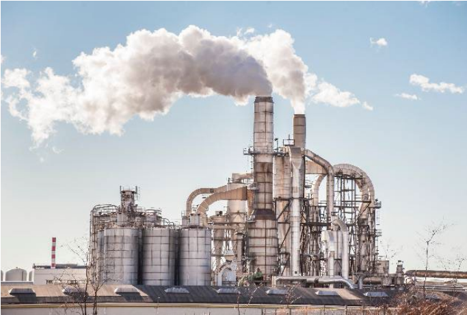
图 1: 造纸和纸浆行业需要大量热能。(© Piller Blowers & Compressors)
