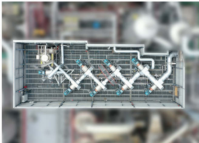
蒸汽压缩热泵技术：串联八台 VapoFlex 实现蒸汽压缩
